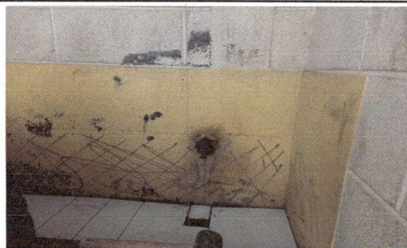
Foto 2: Sustitución de azulejo
