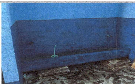
Foto 5: Sustitución de mingitorios
