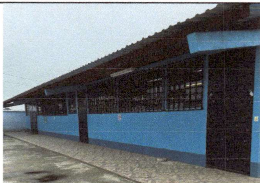
Foto1: Sustitución puertas de metal
