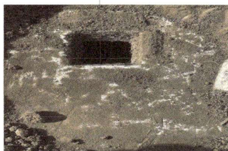
Foto 6: Limpieza fosa séptica 16 m3
