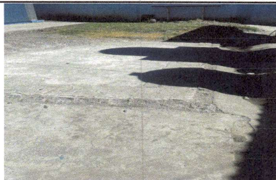
Foto2: Reparación plancha concreto de patio
