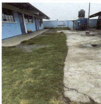
Foto1: Reparación plancha concreto de patio por fisuras
